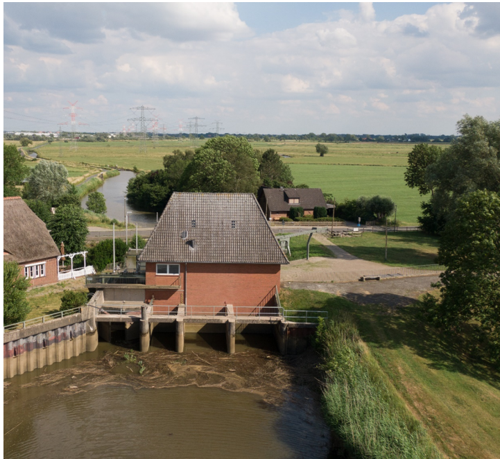
Abbildung 2: Im Schöpfwerk Mühlenhaus musste die größte Pumpe mit 2 m 3 /s Förderleistung erneuert werden.
