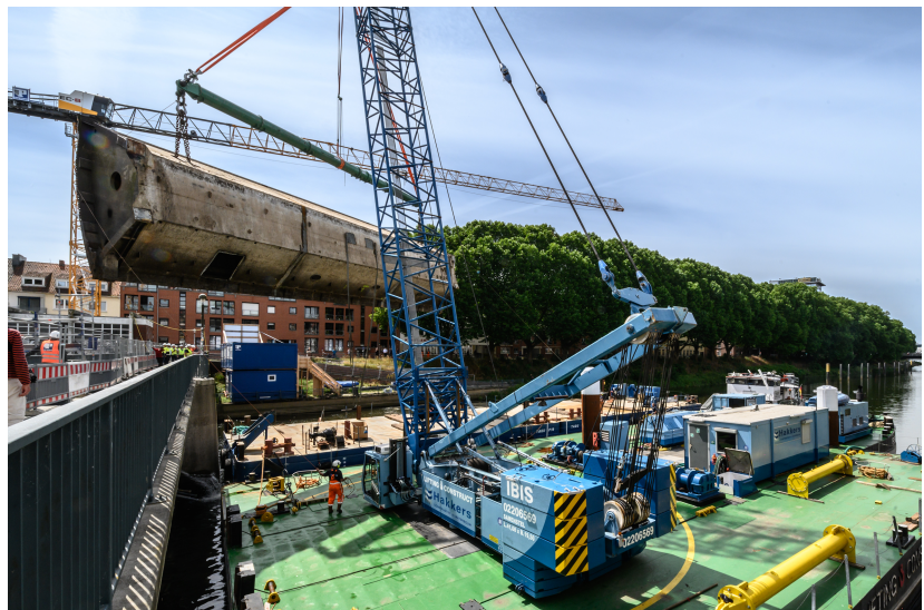
Abbildung 3: Mit dem ersten Baujahr am Wehr Kleine Weser ist ungefähr die Hälfte der Grundinstandsetzung geschafft.
